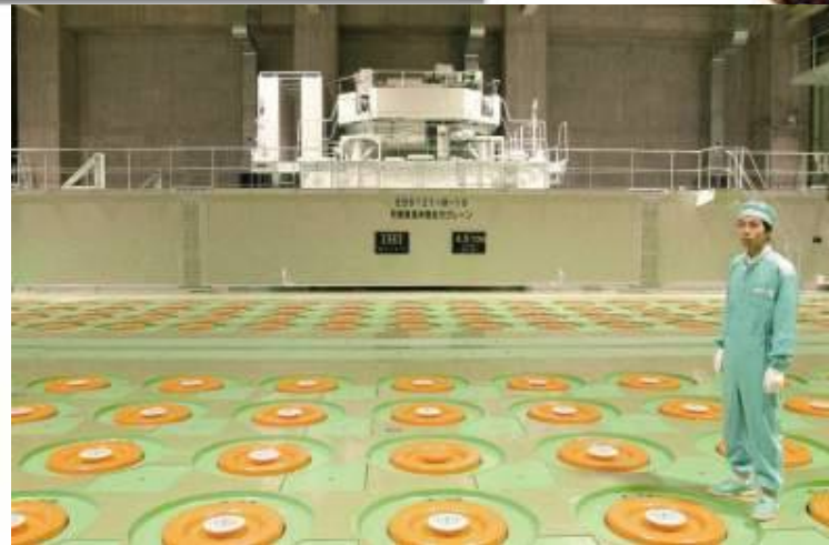
高レベル放射性廃棄物貯蔵管理センター (写真提供：日本原子力研)
